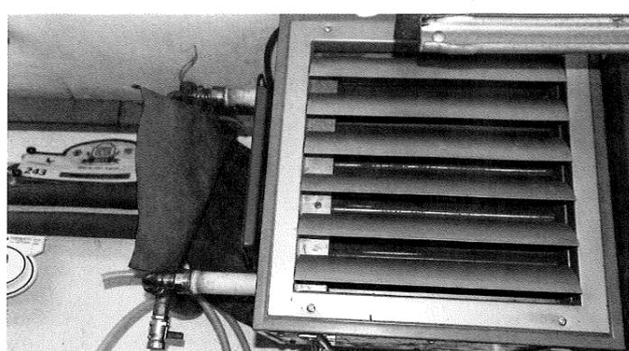
Ein Lufterhitzer mit großem Lüfter und Wärmetauscher mit Anschluss an den Warmwasserkreislauf der Zentralheizung ist eine bequeme, aber mitunter teure Lösung
